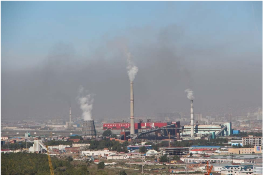
写真 1 石炭火力発電所
